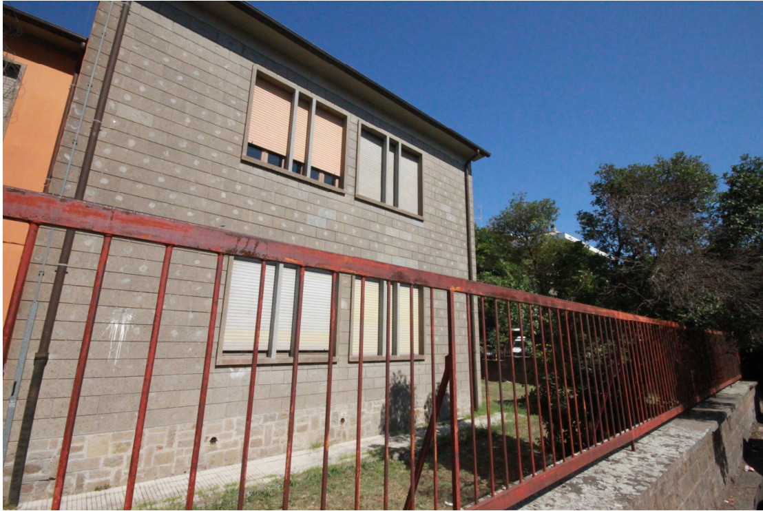
Vista edificio principale su via Minciotti
