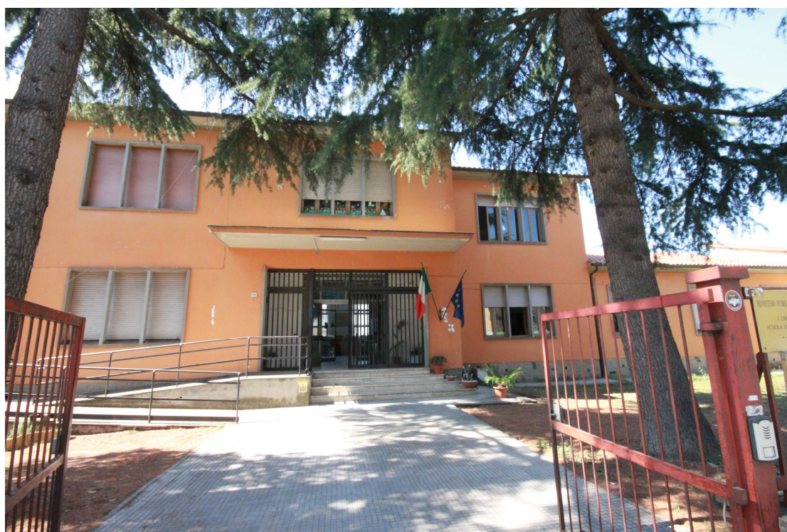
Vista accesso principale A. Volta
