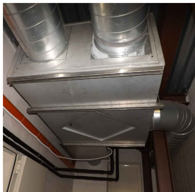
UNITA' DI RECUPERO DI CALORE
