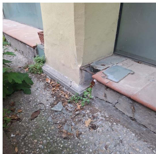
Sopraelevazione pavimentazioni
