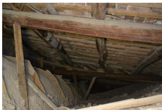
Analisi struttura portante delle coperture
