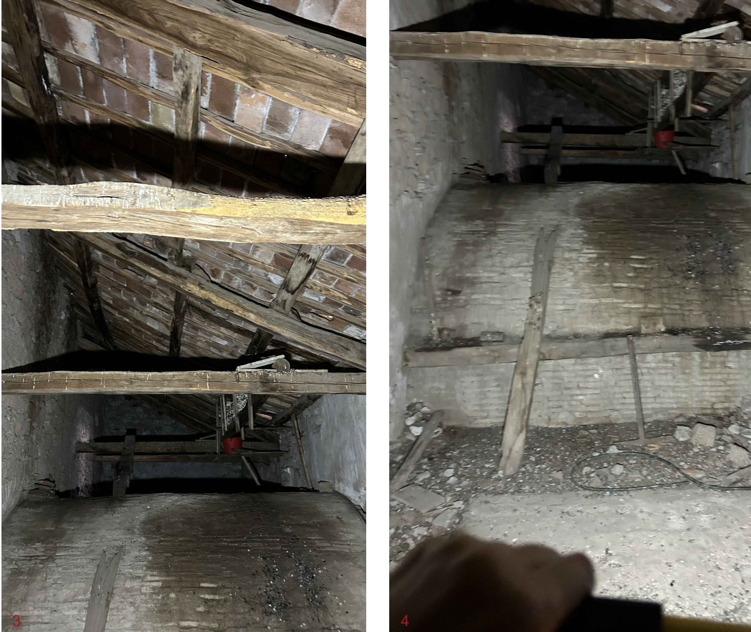
Sottotetto navata centrale
