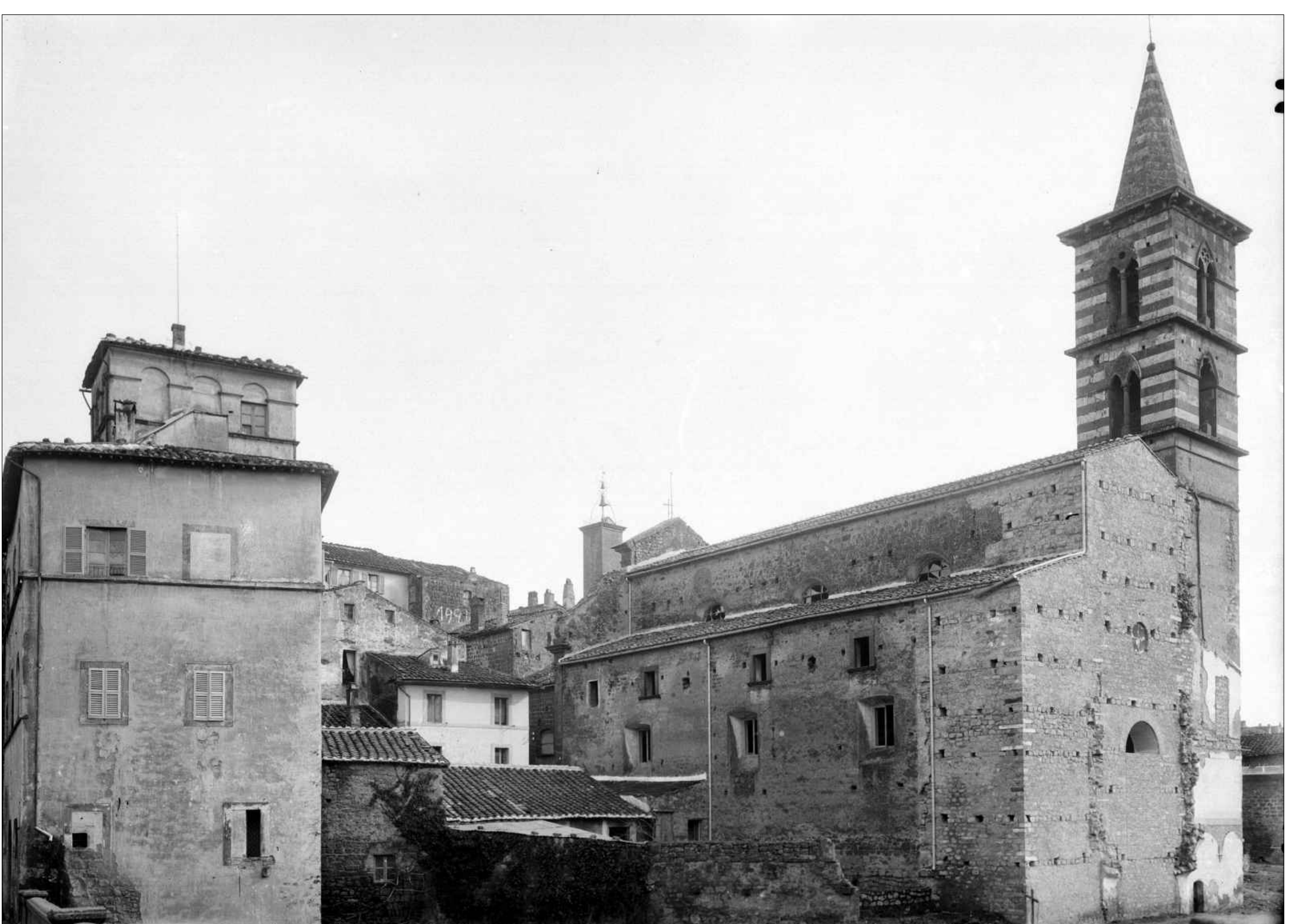
COMPOSIZIONE ORIGINALE DEL CAMPANILE E DELLA FACCIAIA POSTERIORE PRIMA DELL'INTERVENTO DI SMONTAGGIO E RICOSTRUZIONE IN POSIZIONE ARRETRATA 1937
