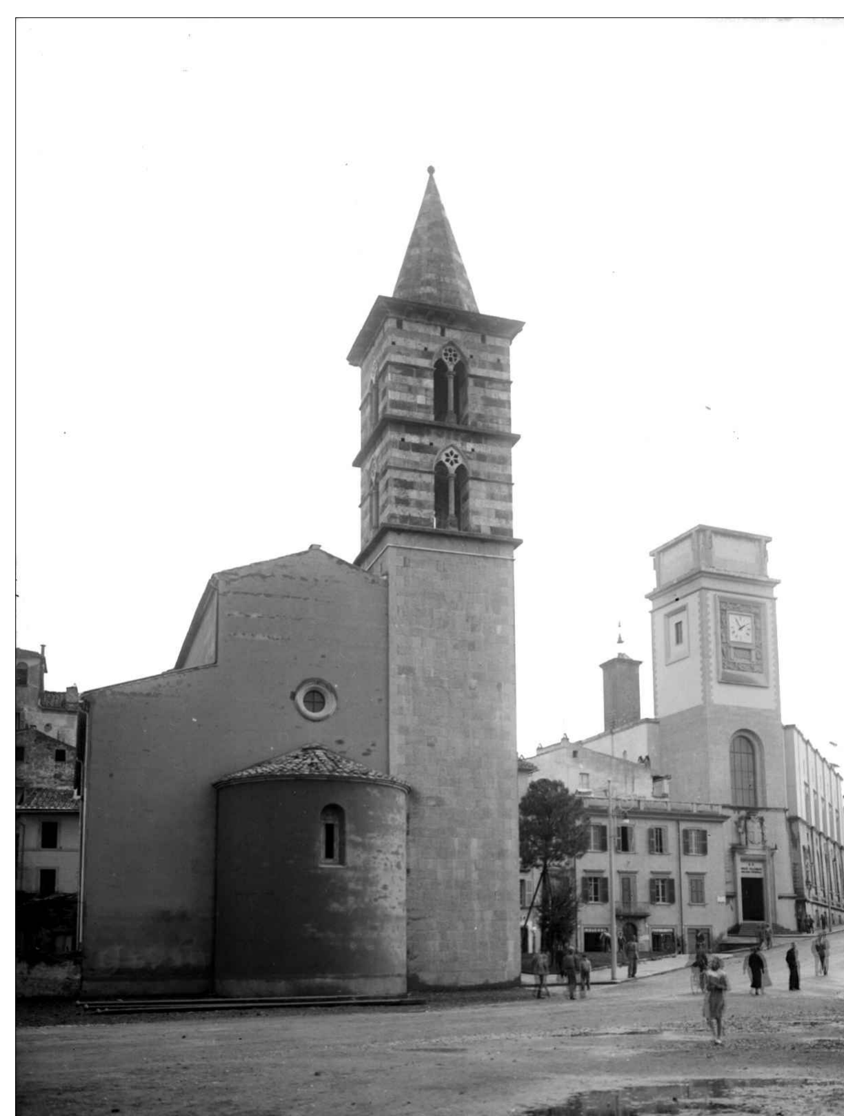
ABSIDE RICOSTRUITO E POSIZIONE FINALE DEL CAMPANILE E DELLA FACCIAIA POSTERIORE CON ARRETRAMENTO DI 4 MT 1938
