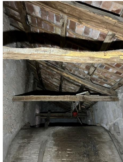
Figura 7 - Stato di fatto della struttura lignea della copertura
