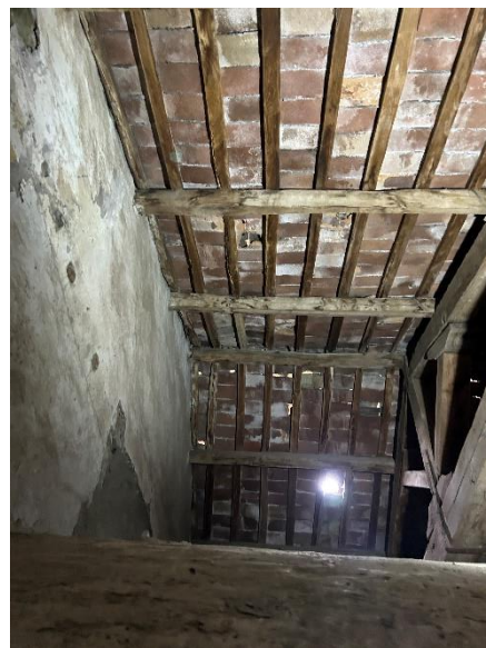
Foto 17 – La capriata verso la facciata
