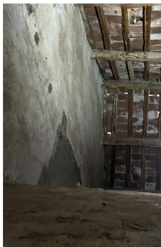
Figura 5 – Il vano finestra di controfacciata parzialmente tamponato
