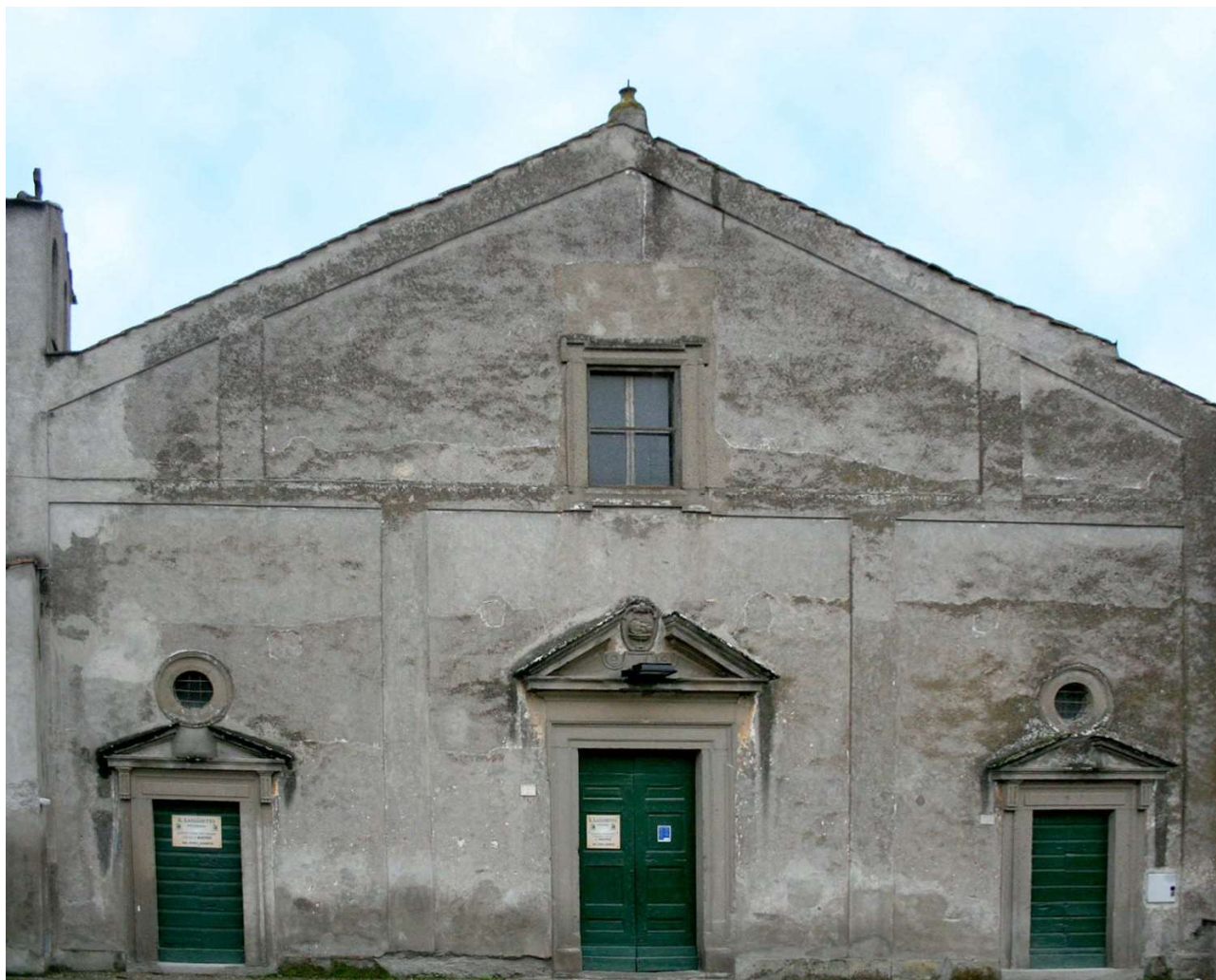
Figura 21-22. Chiesa di S. Giovanni Decollato. Facciata e panoramica dell'interno dell'aula
