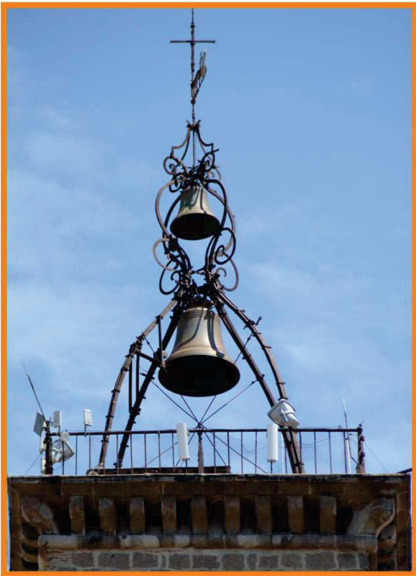
Armatura metallica che sorregge le campane
