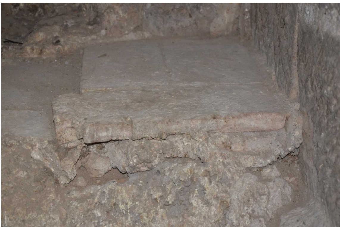
Fig. 23: Pavimento in mattoni in terracotta nel primo ambiente della Zona 2.
