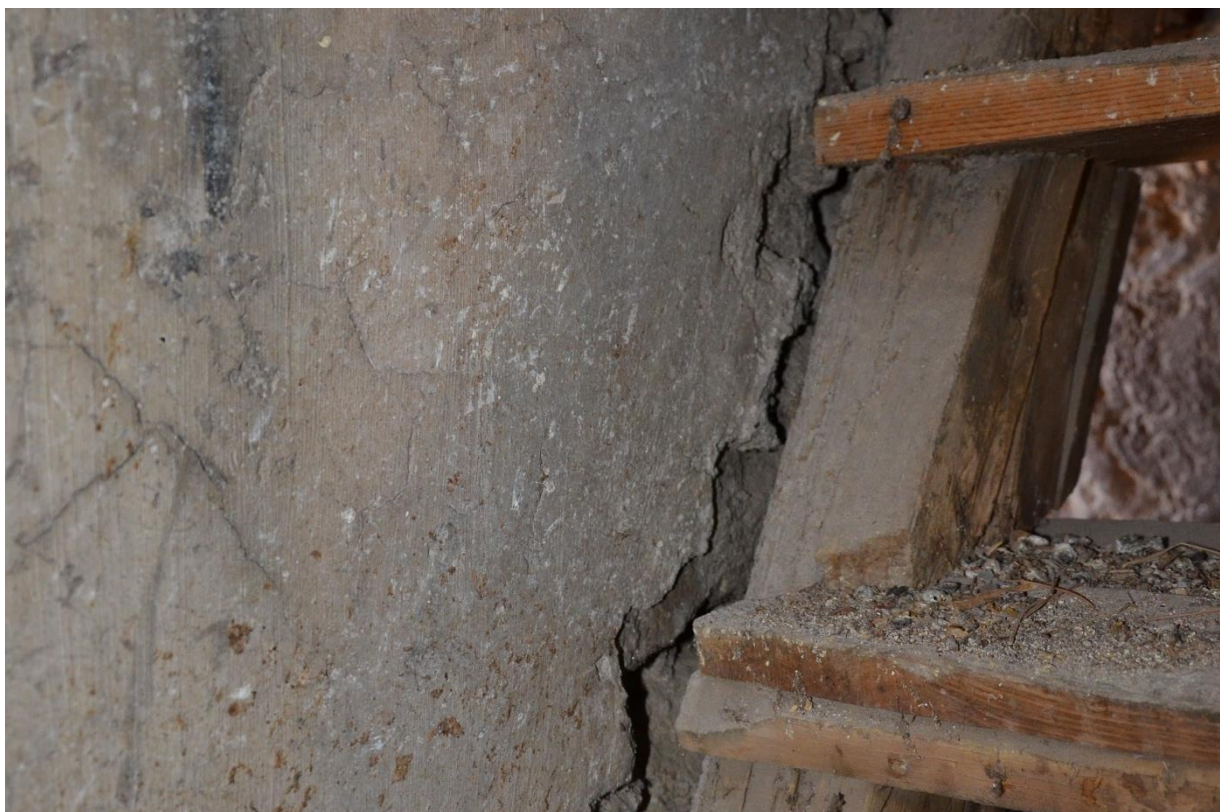
Fig. 36: L'intonaco nella Zona 3 non è stato steso nelle parti di muratura in cui le travi della scalinata sono a contatto con la parete.
