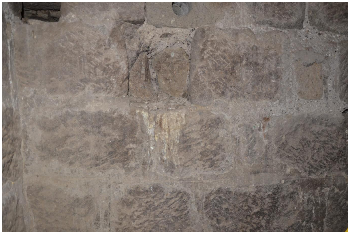
Fig. 4: Muro a blocchi di peperino regolarmente squadretti
