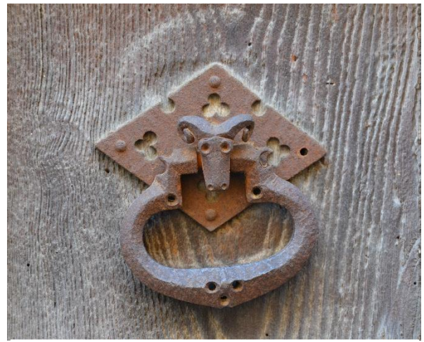
Fig. 17: Uno dei due battiporta in ferro del portoncino di accesso principale alla torre.
