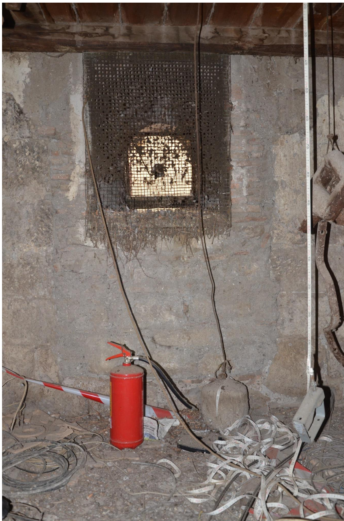
Fig. 27: Affaccio sulla parete sud-est del primo ambiente della Zona 2 chiuso dopo la realizzazione della piccola finestra ovale con lo stemma di Michelangelo Conti.
