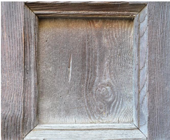
Fig. 16: Particolare della pannellatura in legno di quercia del portoncino di accesso principale alla torre.
