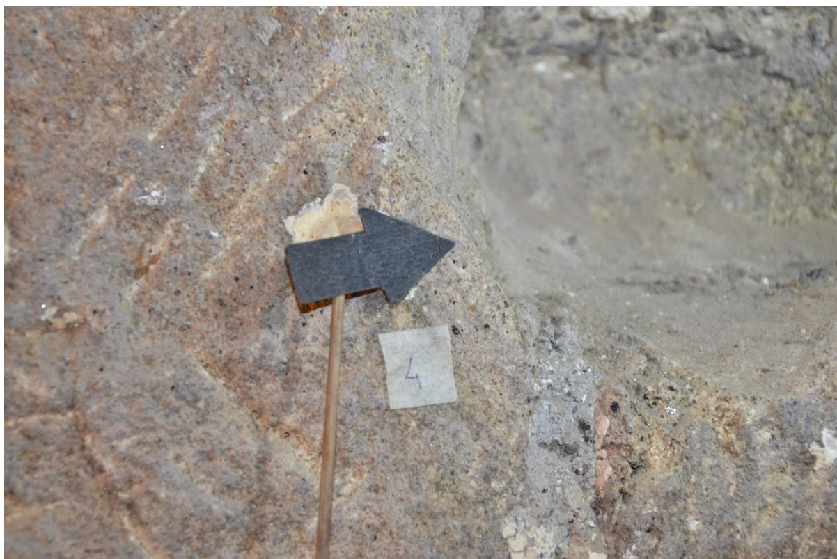
Fig. 3: Punto di prelievo del campione di peperino.
