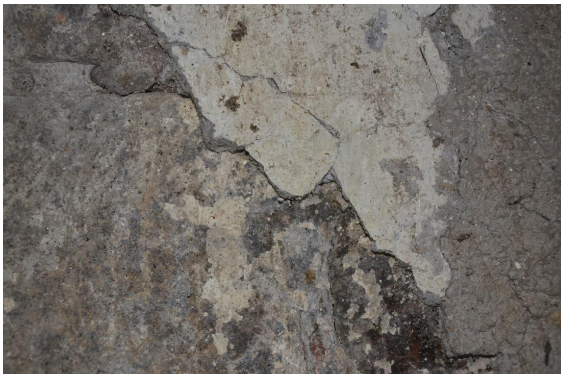
Fig. 22: Intonaco dipinto di bianco presente nelle pareti del primo ambiente della Zona 2.
