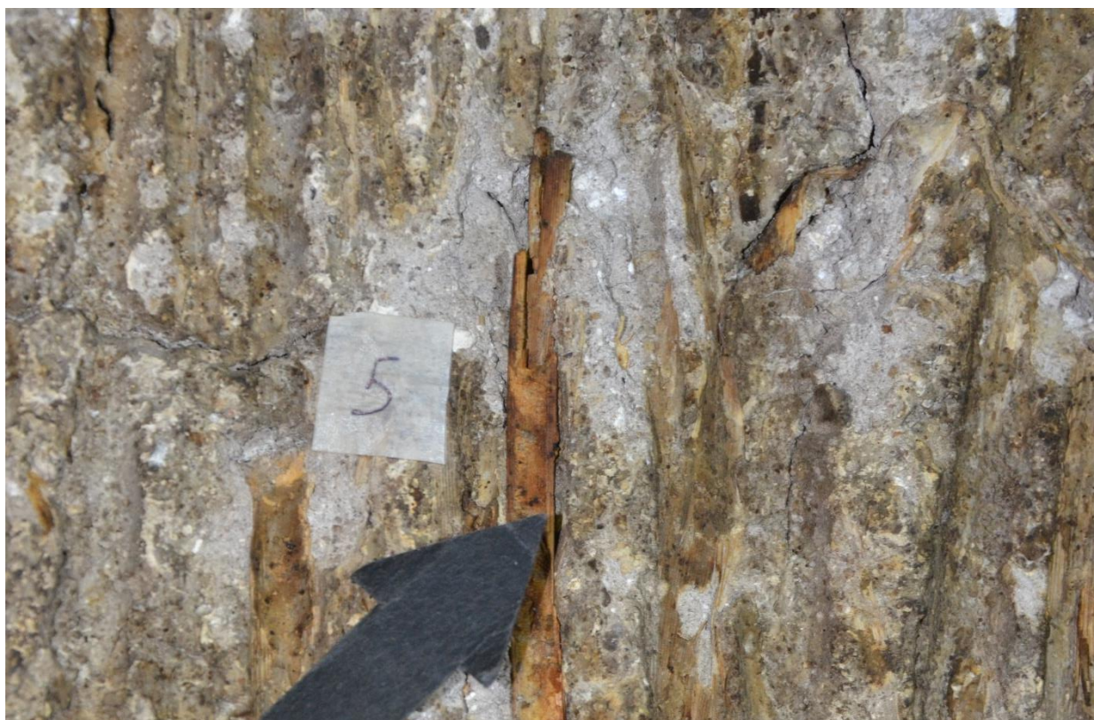
Fig. 8: Cannucce aderenti alla superficie della volta a botte.
