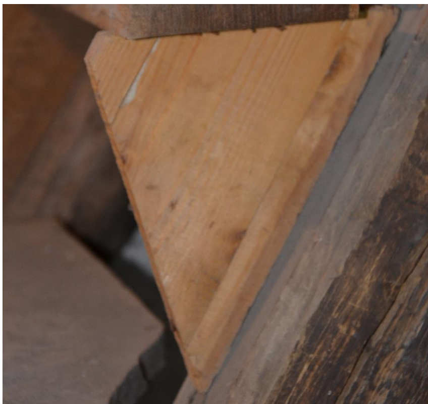
Fig. 10: Elemento della scalinata in legno sostituito di recente.
