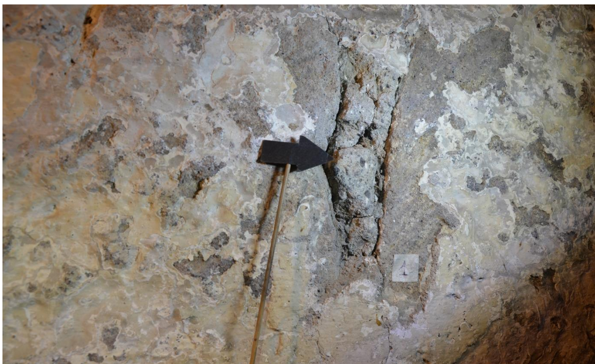
Fig. 5: Malta di allettamento presente tra i giunti della muratura.
