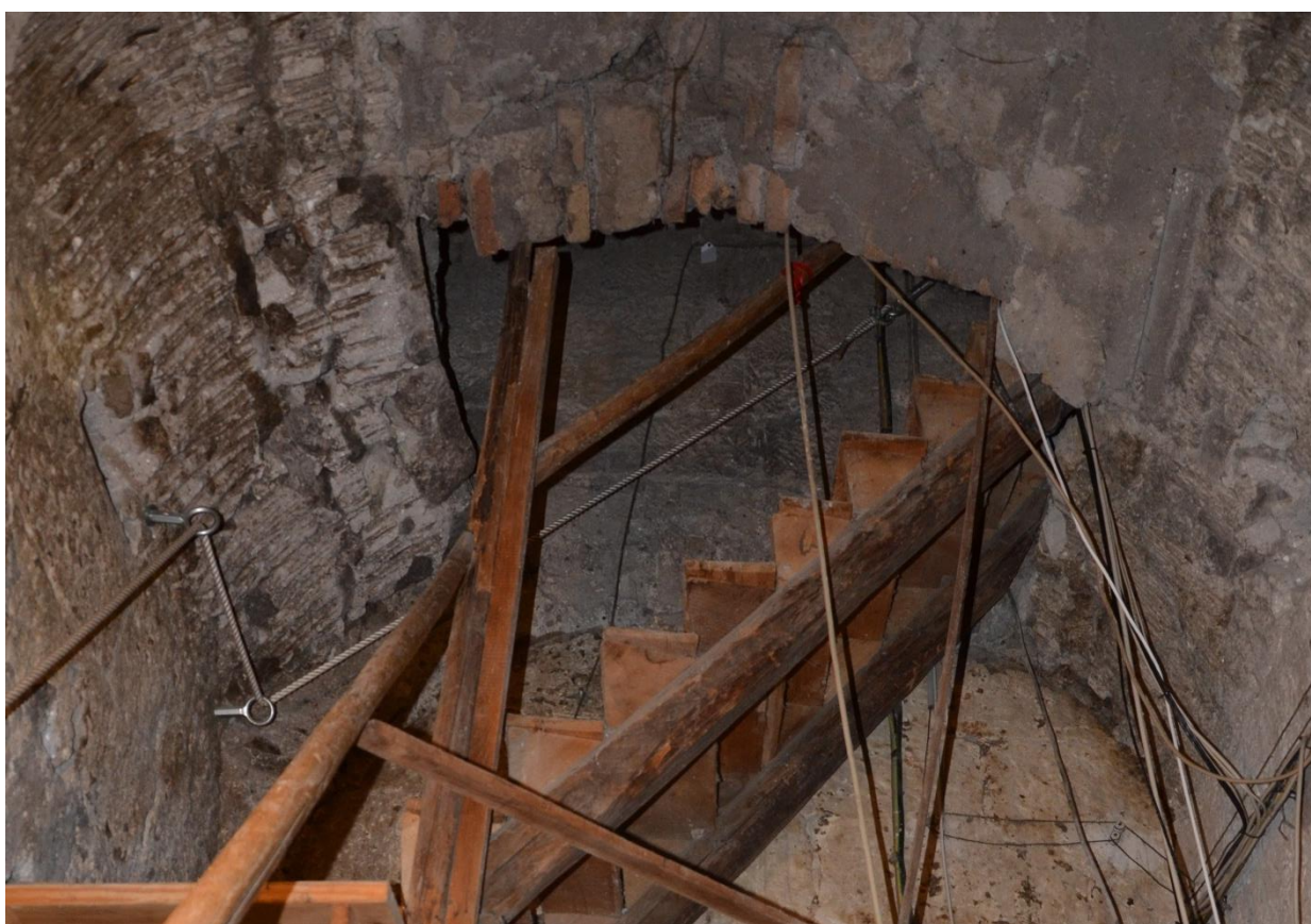
Fig. 7: Volta a botte.
