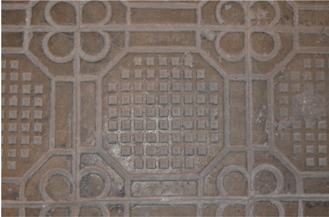
Fig. 15: Particolare del pavimento in mattoni cementizi del piano di calpestio nella Zona 1.
