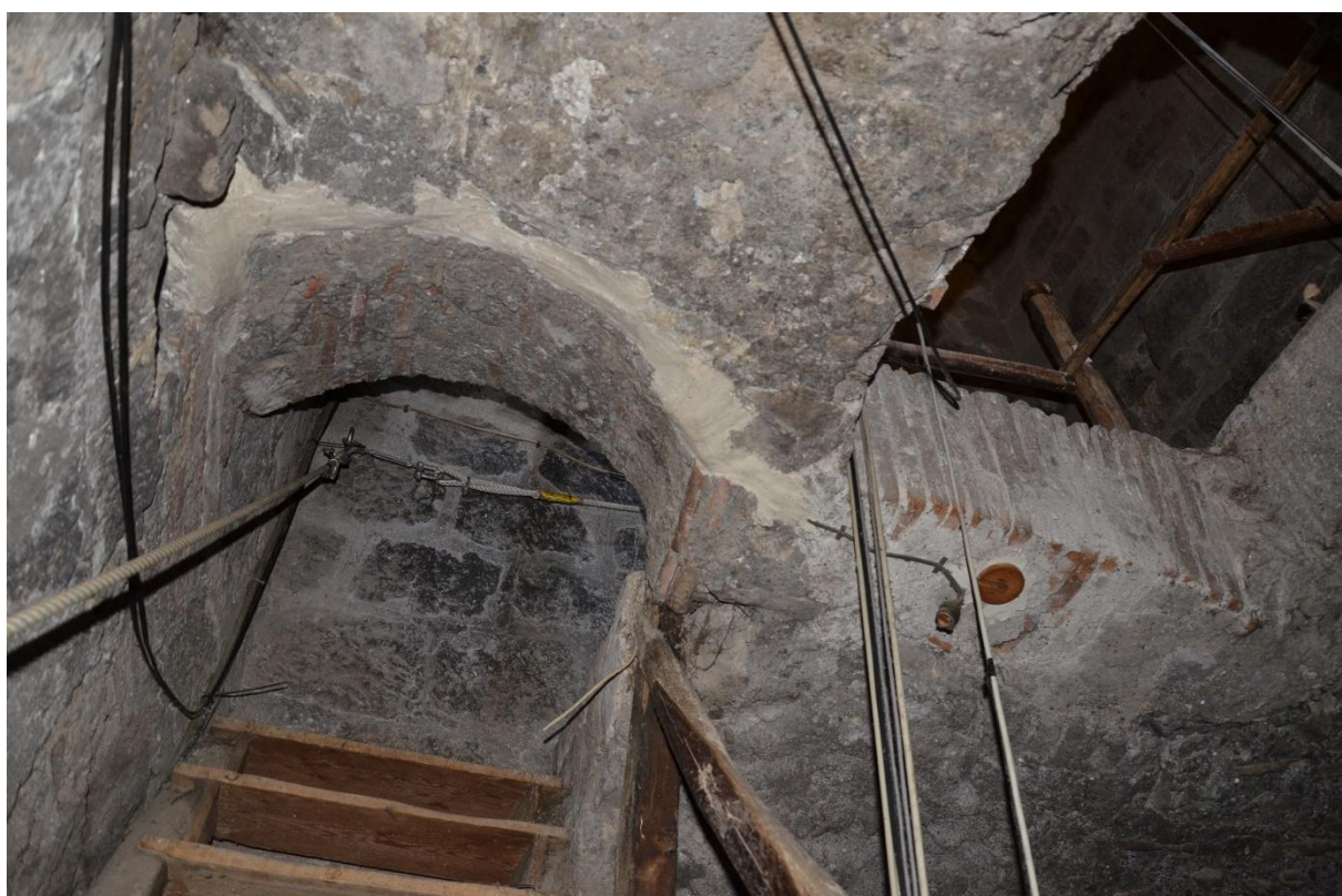
Fig. 32: Volta a botte presente nella Zona 2, con apertura al centro e passaggio per accedere alla Zona 3.
