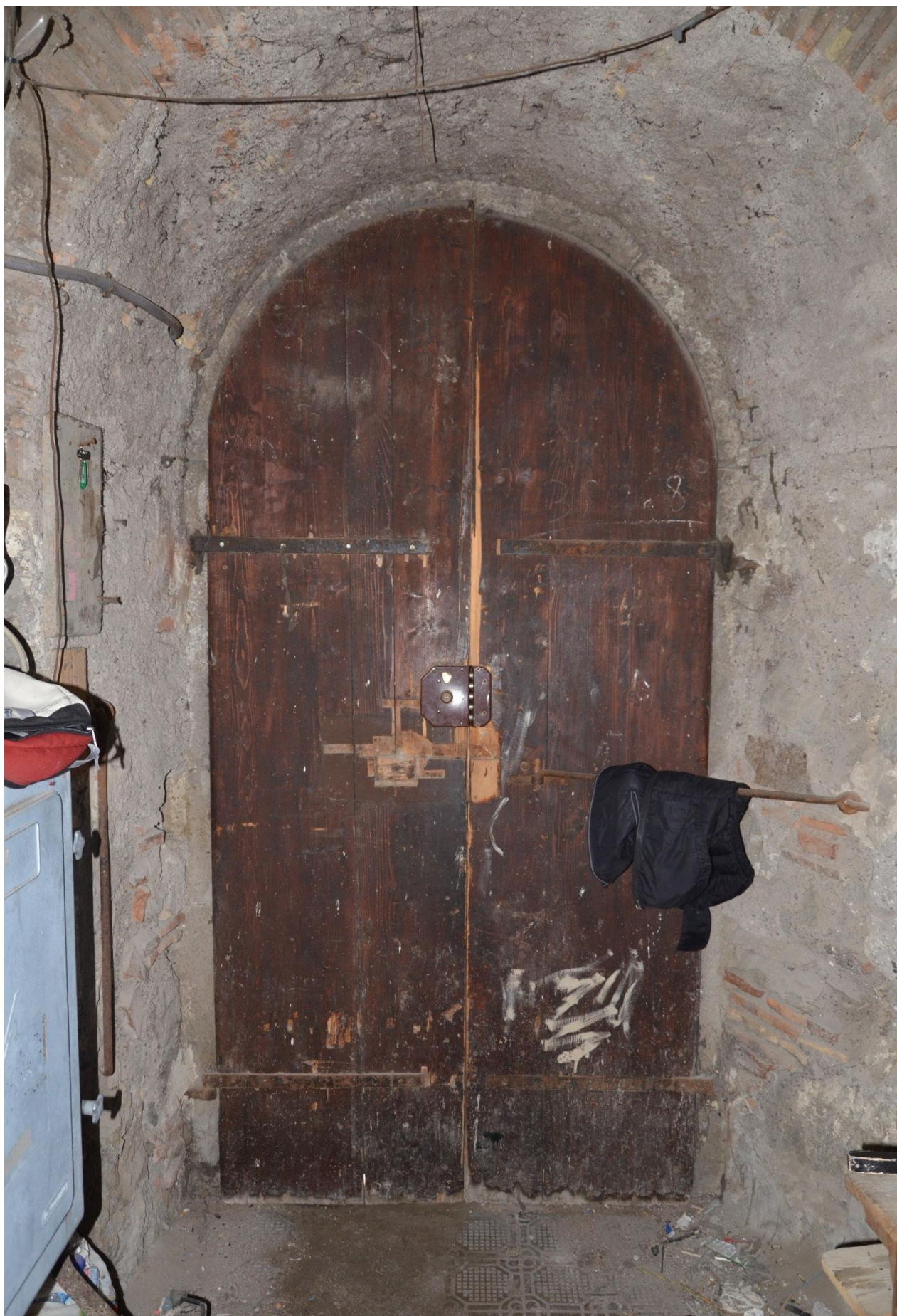
Fig. 18: Portoncino di accesso alla Zona 1 della torre visto dall'interno.
