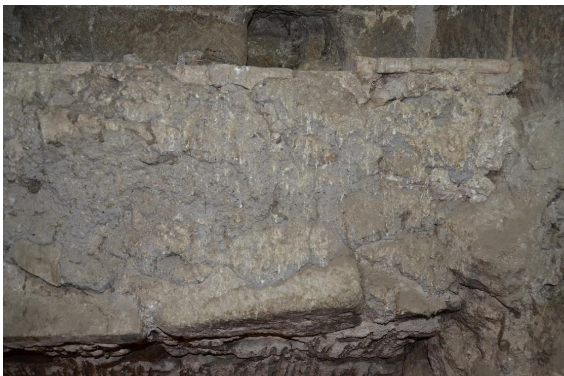
Fig. 21: Presenza di malta da rinzafo nel taglio della volta diversa dalla malta di allettamento originale.
