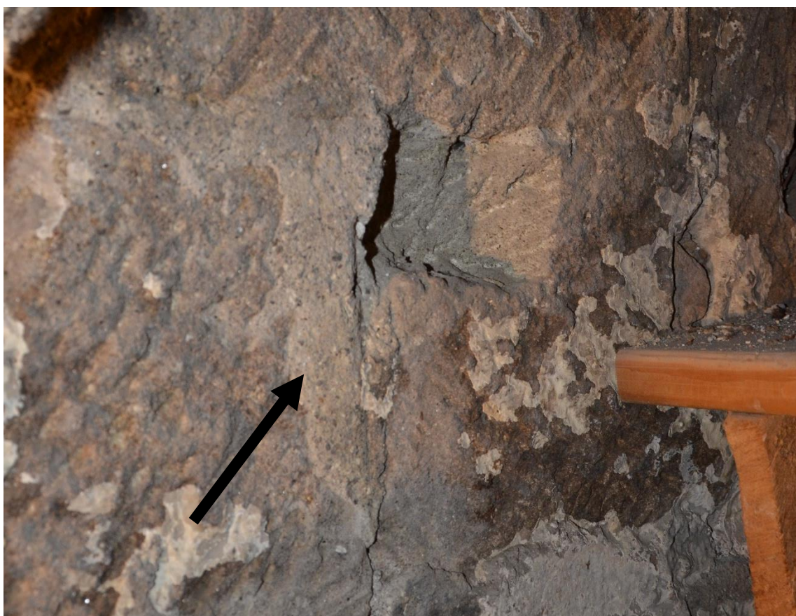
Fig. 11: Tracce di stilatura incisa presente nei giunti dei conci della Zona 1.
