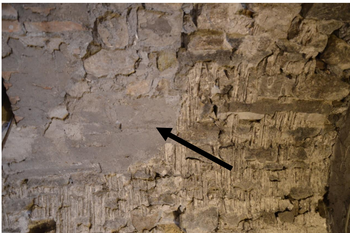
Fig. 20: Intervento di ripristino della volta nella Zona 1.
