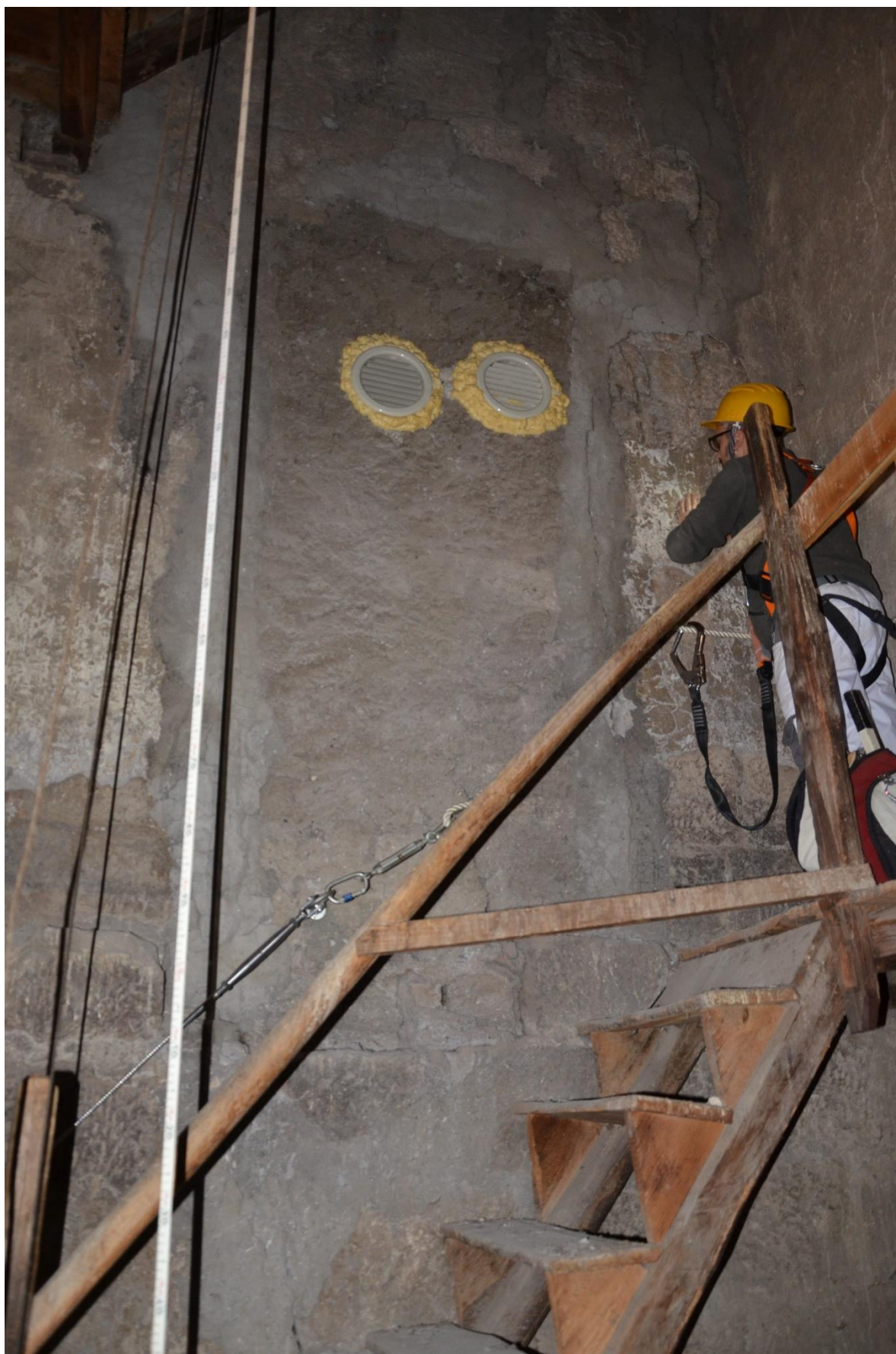
Fig. 28: Porta di accesso al secondo ambiente della Zona 2 oggi murata.
