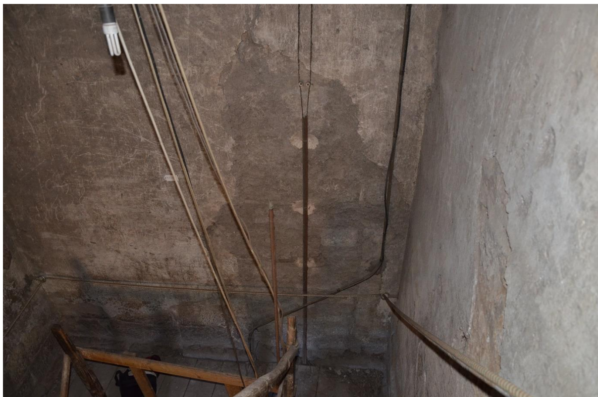
Fig. 29: Apertura murata presente nella parete nord-ovest del terzo ambiente della Zona 2.
