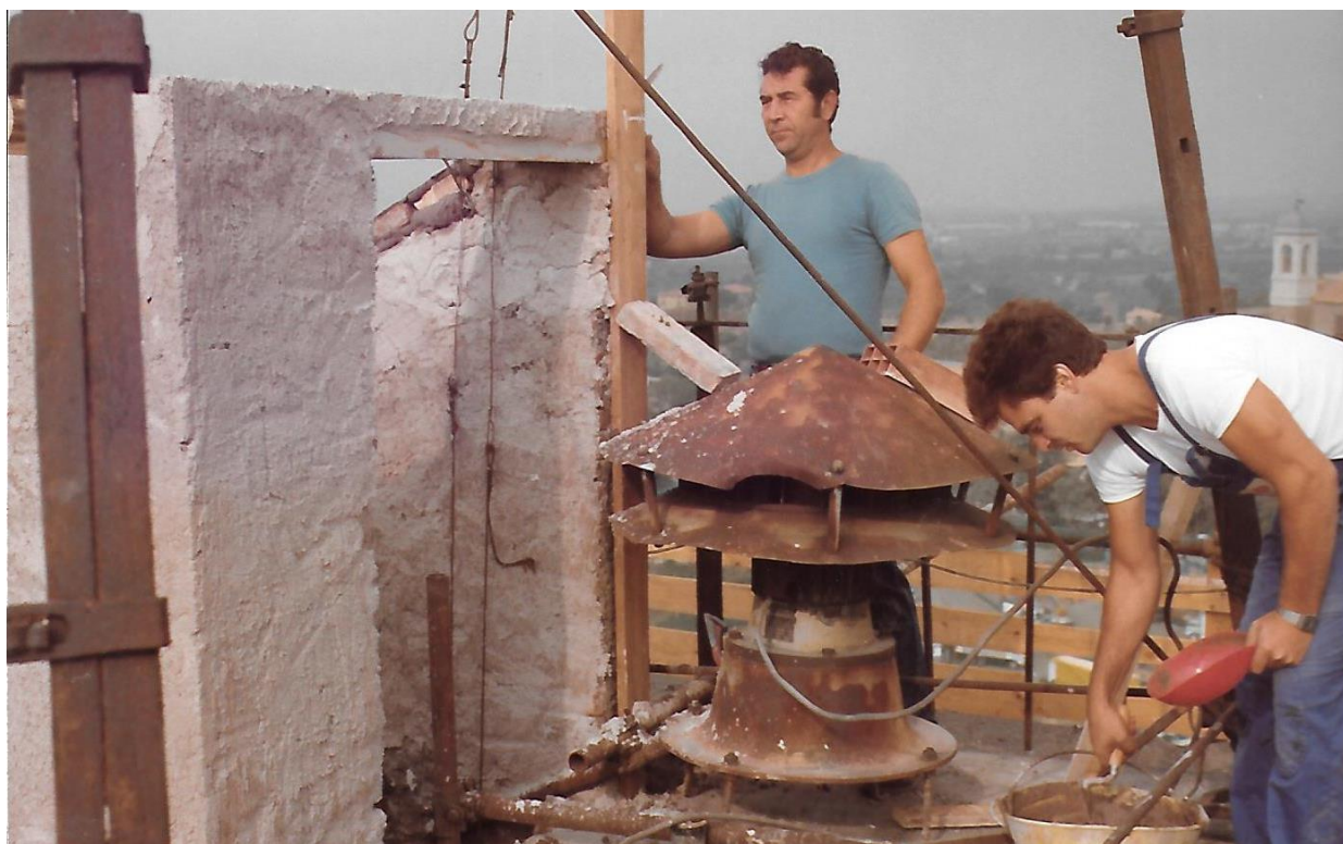
Fig. 43: Ripresa fotografica eseguita nel 1982 durante la realizzazione dell'abbaino dall'Impresa edile del Comm. Aberto Ciorba.
