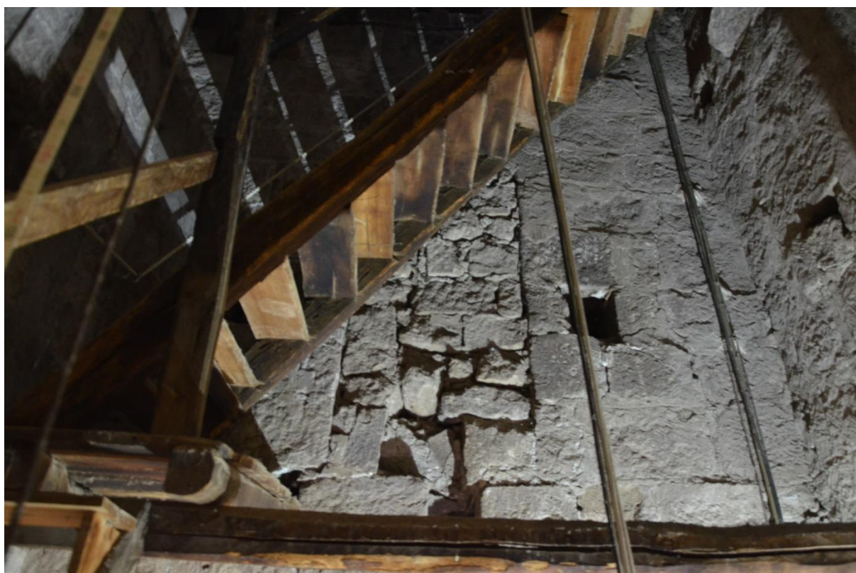
Fig. 30: Porta murata presente nel terzo ambiente della Zona 2.
