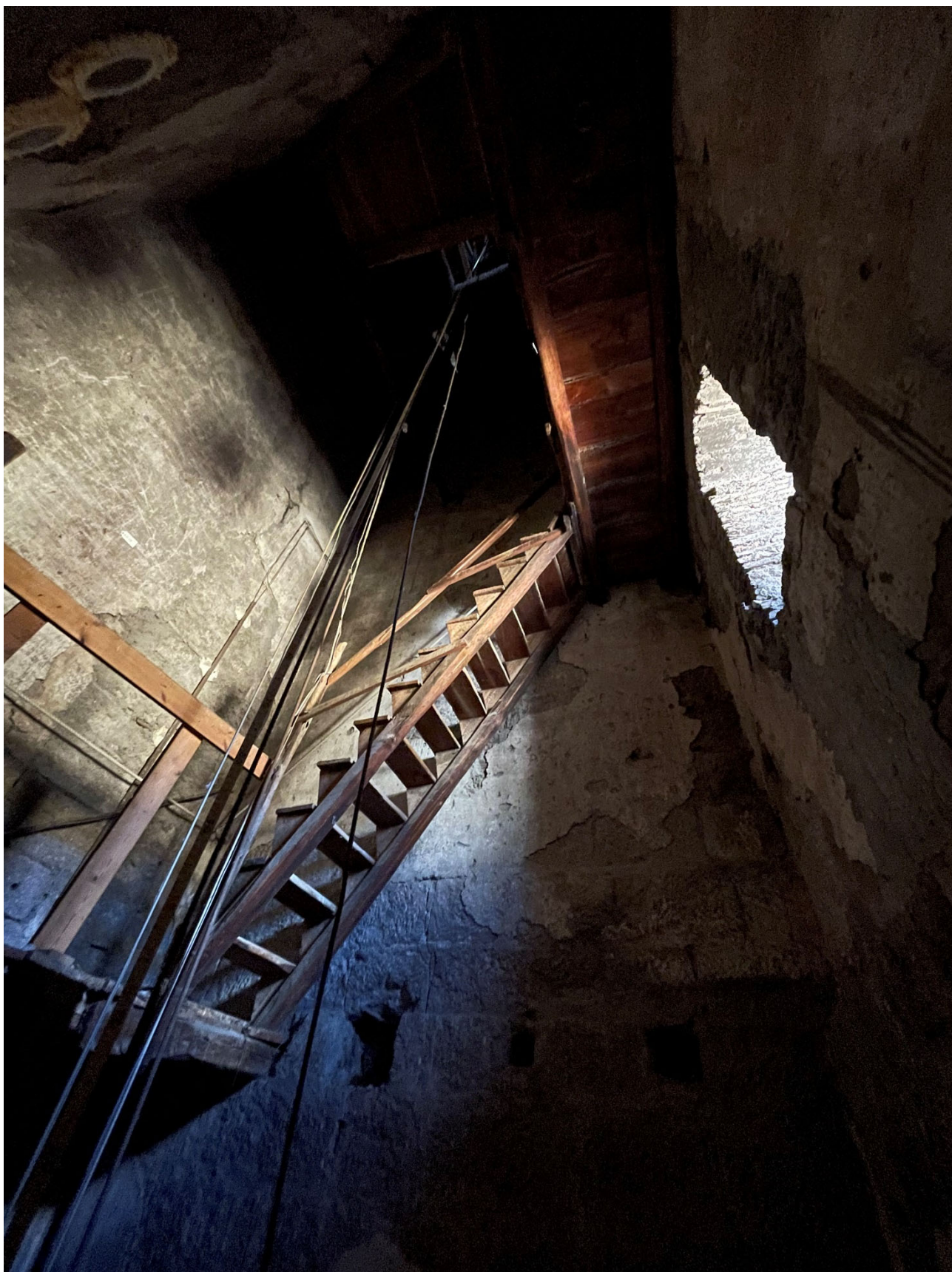
Interno della torre
