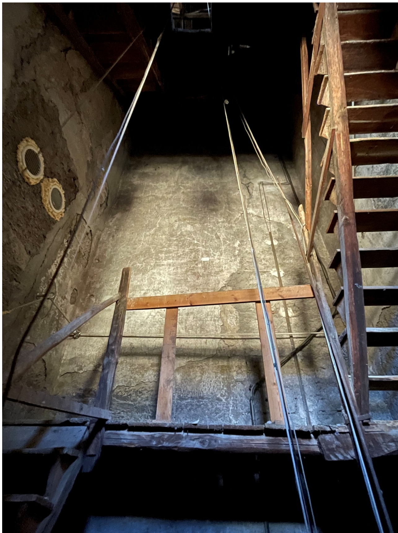
Interno della torre
