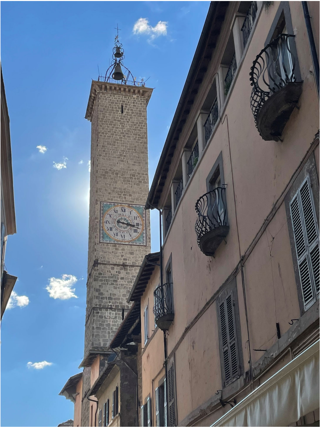
Prospetto laterale della torre da via Roma
