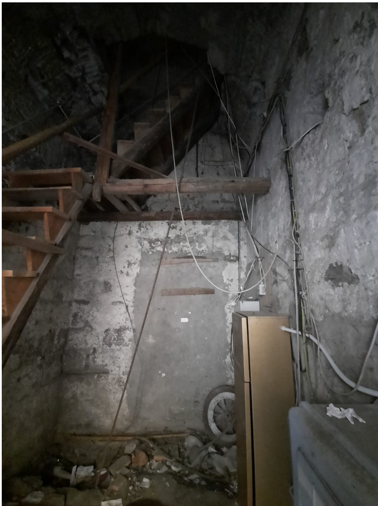
Interno della torre, piano terra, ingresso da via Roma, in cui si notano la scala lignea esistente, la tamponatura e i residui di tinteggiatura a calce sulla parete di fondo e i mobiletti per le utenze da rimuovere
