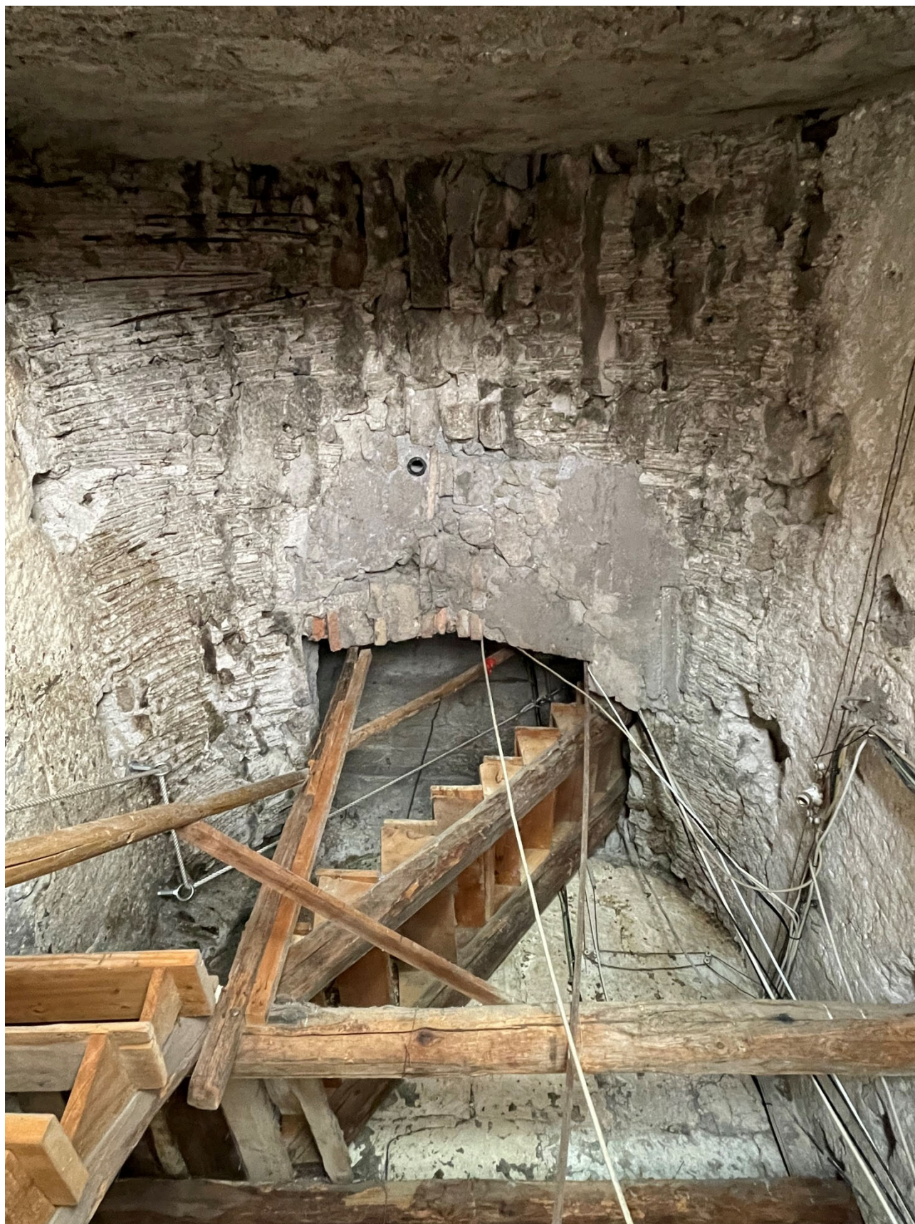
Volta con incannucciato al piano terra
