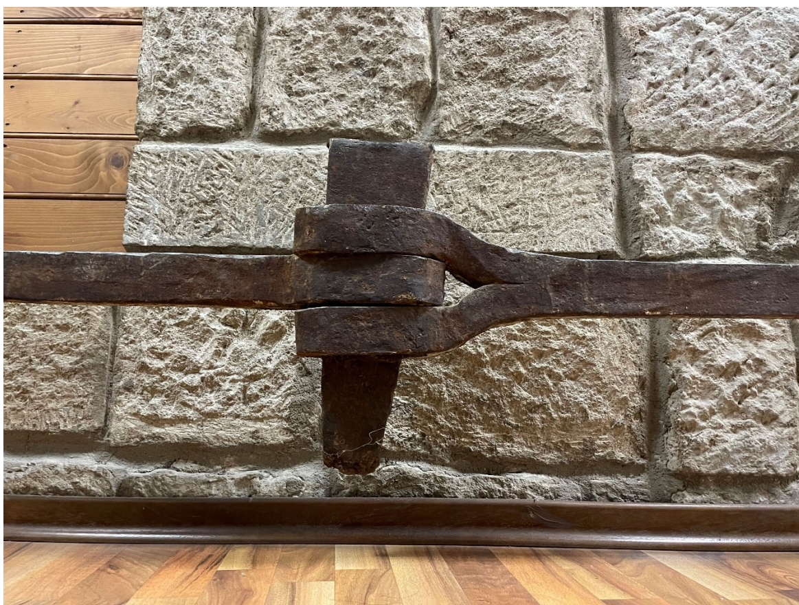
Catene con particolare sul fianco esterno della torre, viste dall'interno degli uffici comunali
