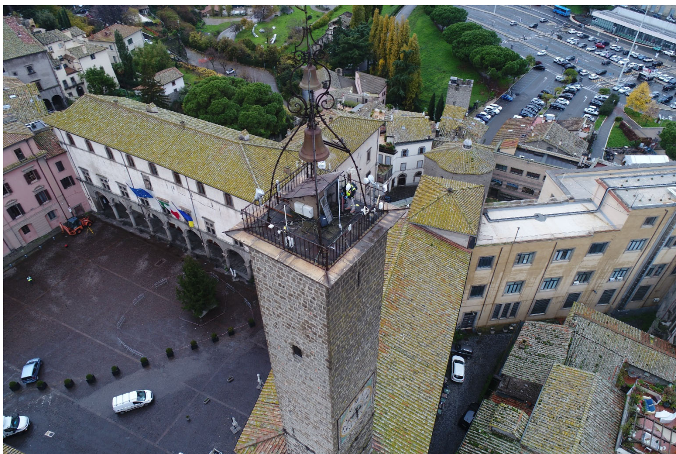
Foto del terrazzo di copertura della torre con l'abbaino di uscita ed il castello delle campane
